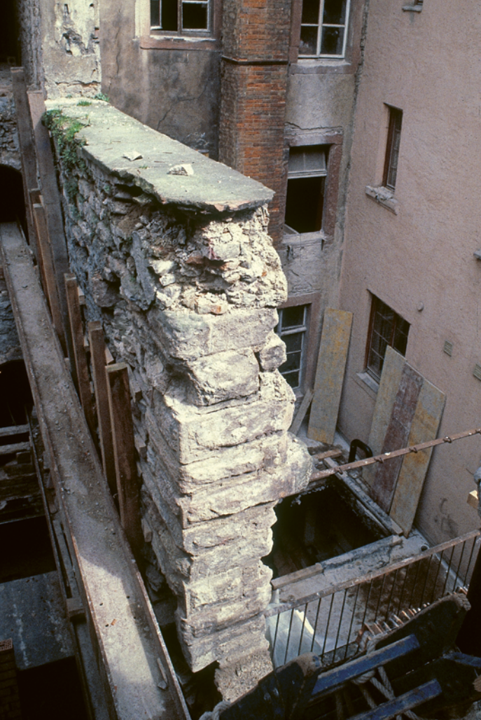
106 Reste eines Wohnturms an der Schneidergasse 12, Fotografie von 1983. — Im Hinterhof der Schneidergasse 12, der heute mit Glas überdeckt ist, befinden sich Teile einer Mauer aus sandsteinernen Bossenquadern. Die Mauer gehörte zu einem Wohnturm aus dem 13. Jahrhundert, der später ausgekernt wurde.
